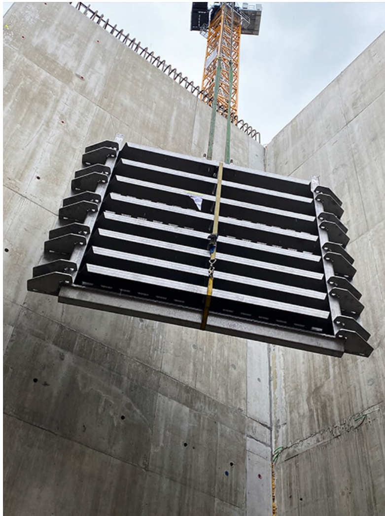
Anlieferung eines Wey Normschütz 2.4 mit einer Höhe von 5.40 m für ein Wärme- und Kältenetzwerk in der Schweiz.
